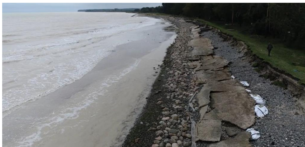
Figur 4-1 Skader på diget på strækning uden bølgebrydere. Foto fra Ulvshale-Fællesskov digelag efter stormen Babet.
